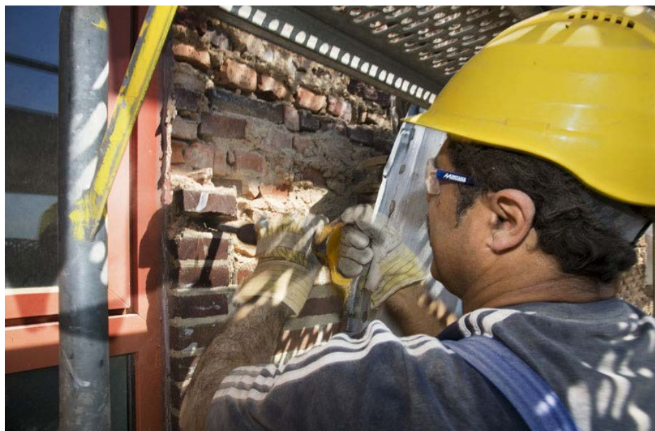
Figura 61 Remoção manual da alvenaria de tijolo e demolição do anexo situado a oeste
