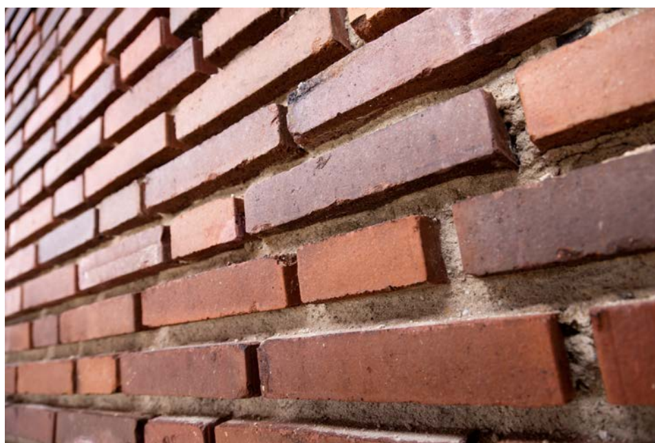
Figura 4 73 km de juntas preenchidas
