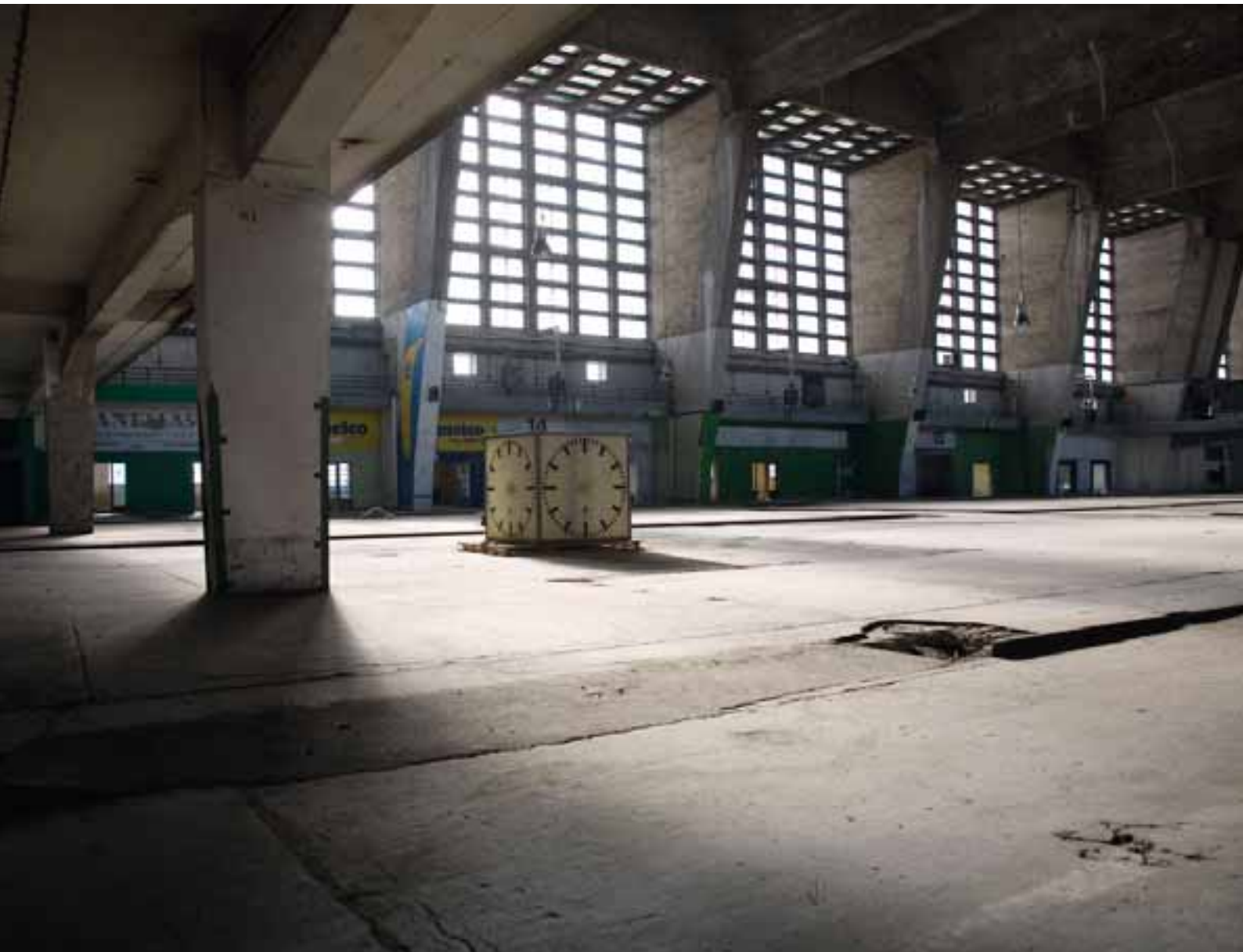
Vista interior do antigo Grossmarkthalle , edifício classificado (Fevereiro de 2008). O Grossmarkthalle , desenhado por Martin Elsaesser, era o edifício com o maior vão livre em cimento armado do mundo quando ficou concluído em 1928.
