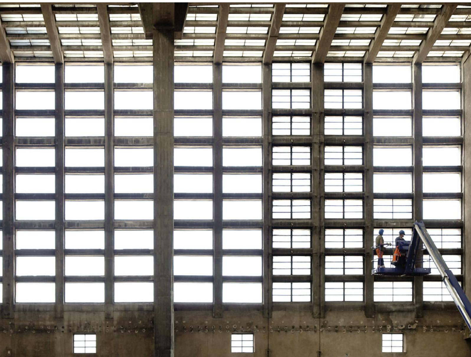
Vue intérieure de la façade à quadrillage de béton. La restauration de la *Grossmarkthalle* est un élément important des travaux de construction. L'aspect fondamental du bâtiment sera conservé, les façades et les surfaces étant restaurées conformément à l'arrêté de préservation du site.
