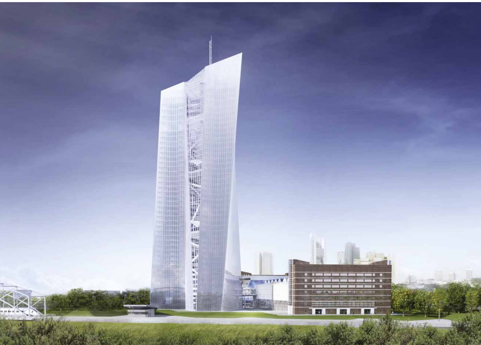
Pohľad na sídlo ECB z východu. Nové sídlo ECB, ktorého výstavba prebieha na základe návrhu architektonickej kancelárie COOP HIMMELB(L)AU, má byť dokončené do konca roka 2013. Návrh pozostáva z troch hlavných stavebných prvkov: dvojitej kancelárskej veže, budovy Grossmarkthalle a vstupnej budovy
